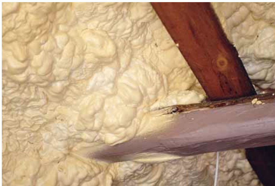
Isoleringen är ett skum man sprejar på och som expanderar hundra gånger.
